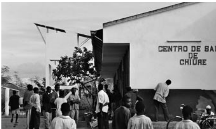
Das Gesundheitszentrum von Chiúre Sede. Im Hintergrund der neue Wasserturm mit Solarpanels.
