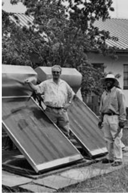
Kurt Künzle und ein lokaler Bauunternehmer bei einer Solaranlage des «Matelle Health Center».
